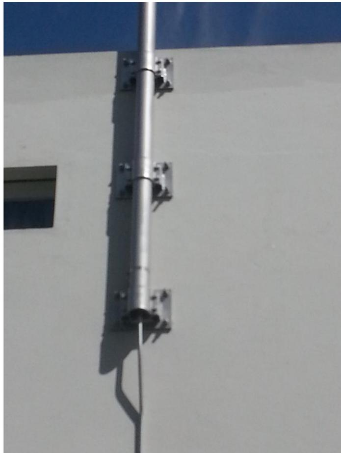
Der Mast wurde an einer Wand mit Schellen befestigt.
