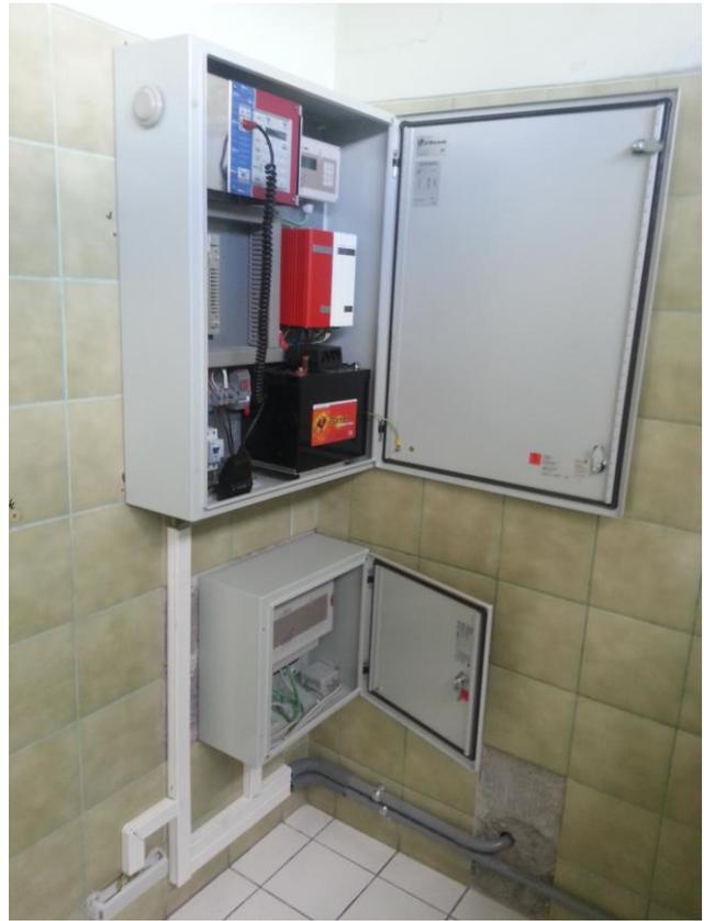
Die beiden Erdbebenmelder „Master“ und „Submaster“ wurden in einem Abstand von ca. 100m in Schutzkästen an Betonpfelern installiert. Das Sirenenkabinett wurde zusammen mit dem Master in einem Raum installiert.
